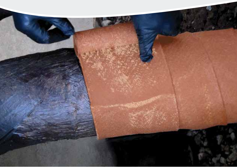
Un système simple à appliquer, la bande HT-3000 Wax-Tape requiert une préparation de surface minimum.
