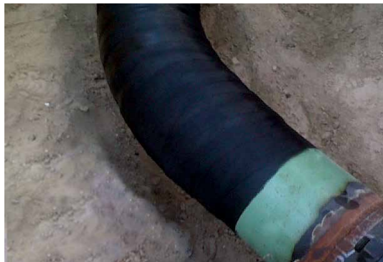
Pour les applications nécessitant une protection mécanique, Trenton recommande l'utilisation d'une bande de protection mécanique. La bande Trenton MC Outerwrap procure une excellente protection mécanique avec un temps de durcissement rapide.
