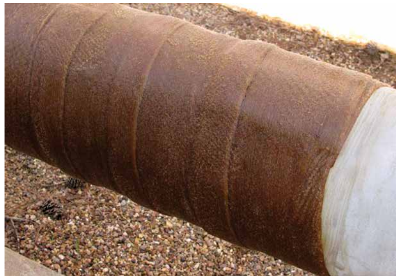
Après l'application du primaire, la bande doit être enroulée en spirale avec un recouvrement minimum de 30 mm. Les spires doivent être scellées.
